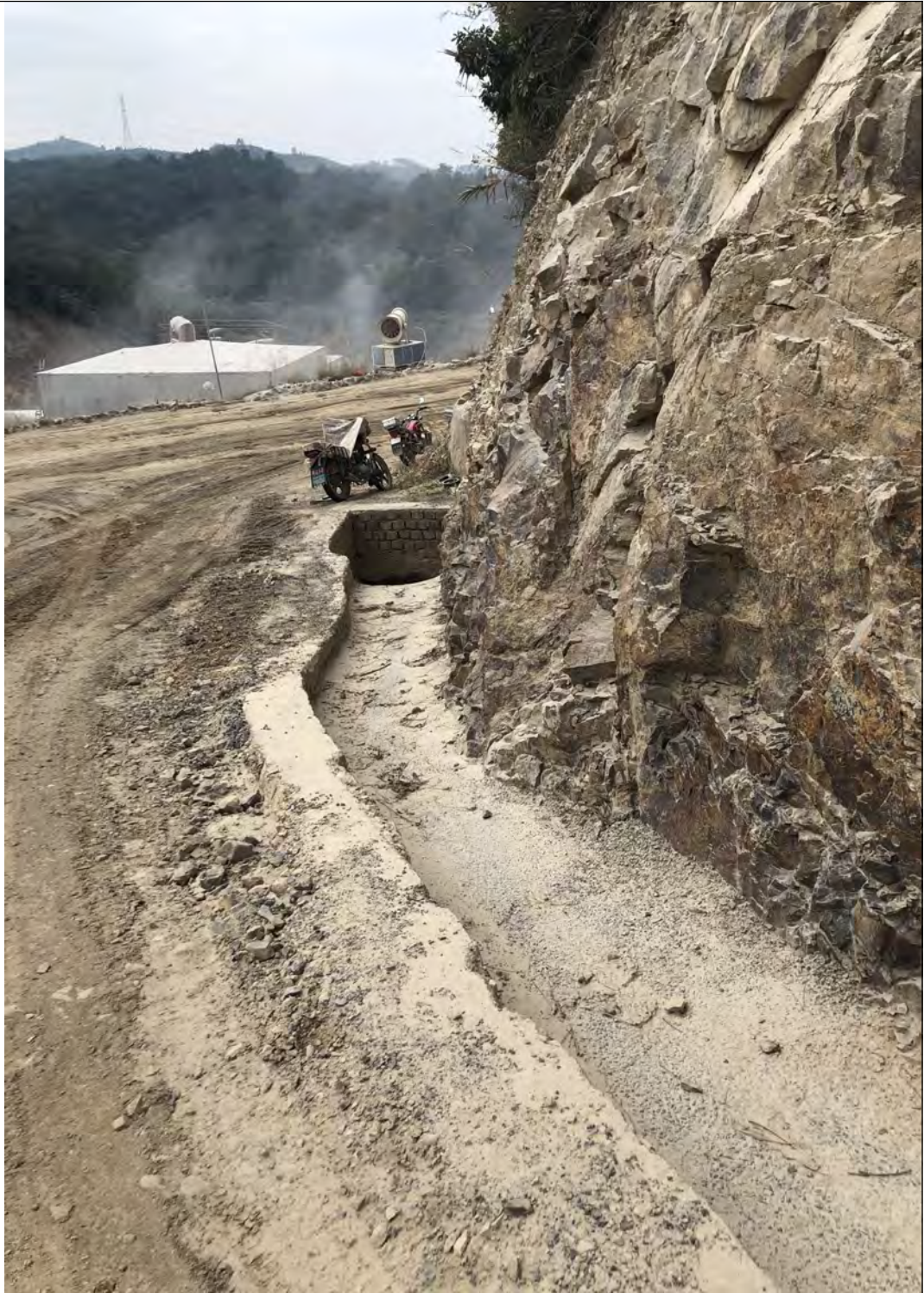
矿山道路排水沟
