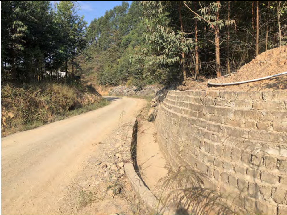
矿山道路排水沟
