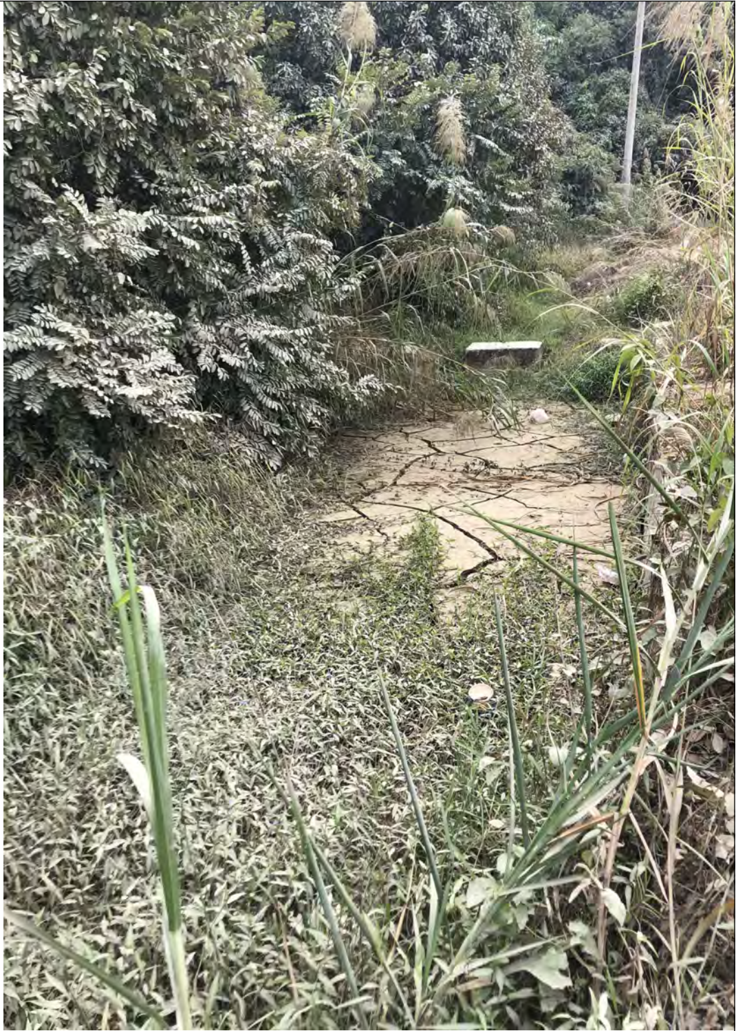
临时堆料区沉砂池
