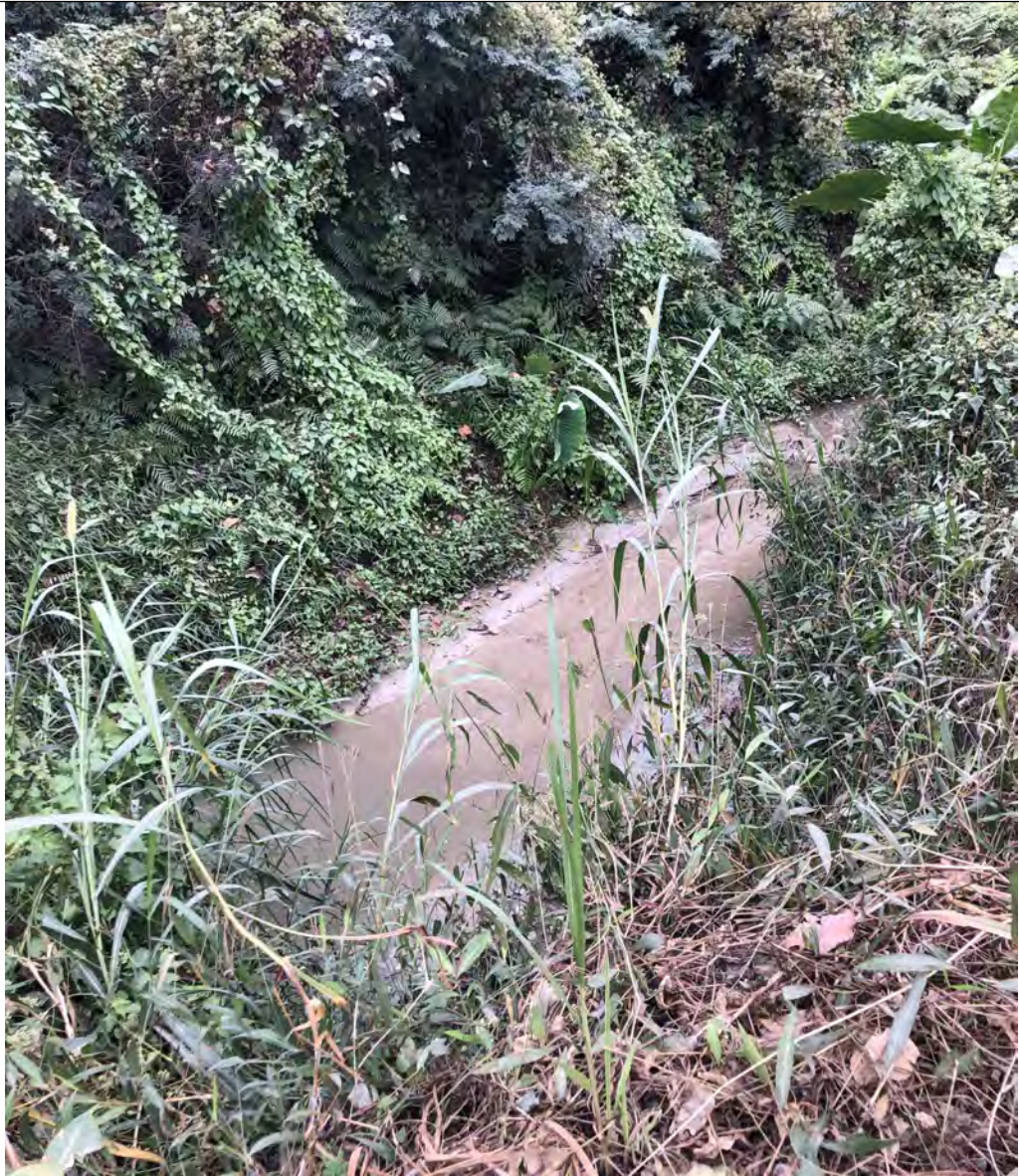
临时堆料区外围截水沟
